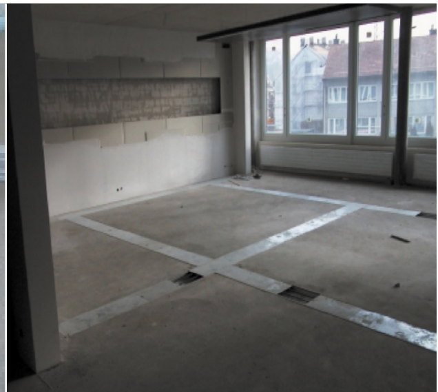
Keine Aufschüsselung und keine Rückschüsselung des Randes
